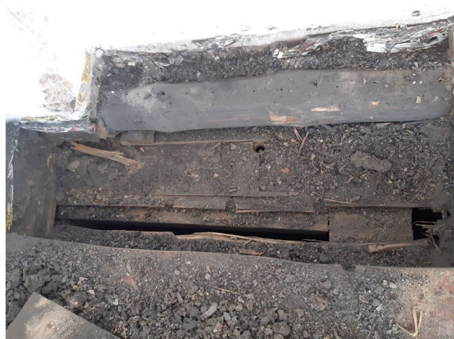
foto/46/ Pohled na výměnu u komína v sondě S14
