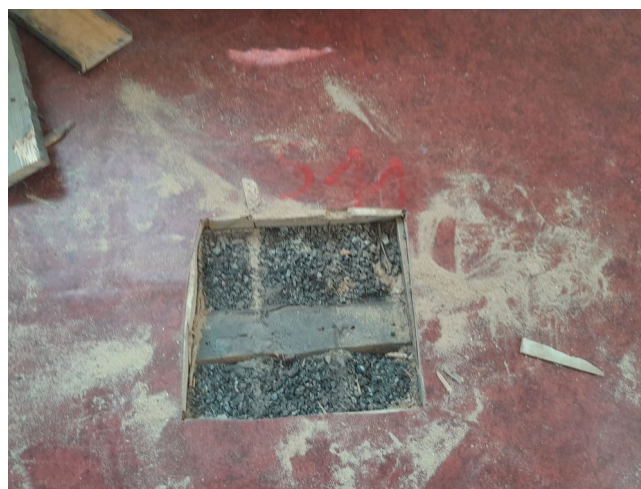
foto/65/ Pohled na otevřenou sondu S11 s odhaleným polštářem
