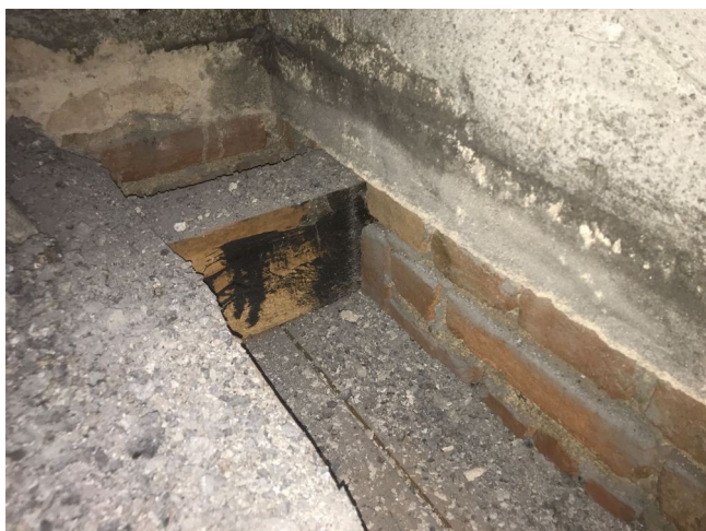
foto/28/ Pohled na zhlaví trámy v sondě S4
