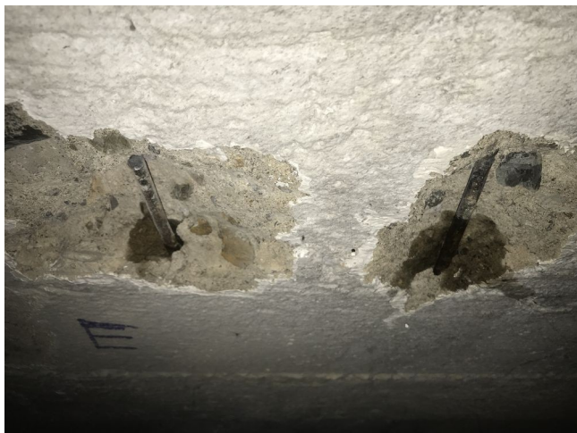
foto/84/ Zkarbonatovaný průřez betonu
