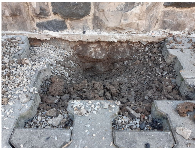
foto/14/ Ověření přítomnosti svislé hydroizolace
