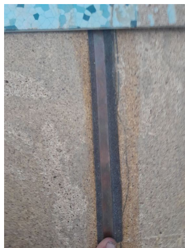
foto/73/ Pohled na zemnicí pásek pod PVC v sondě S13
