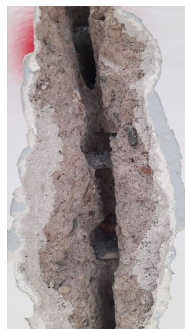
foto/93/ Pohled na odhalenou hlavní nosnou výztuž
