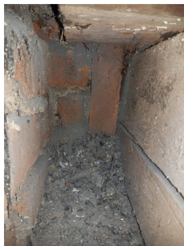
foto/55/ Pohled na zhlaví trámy v sondě S16
