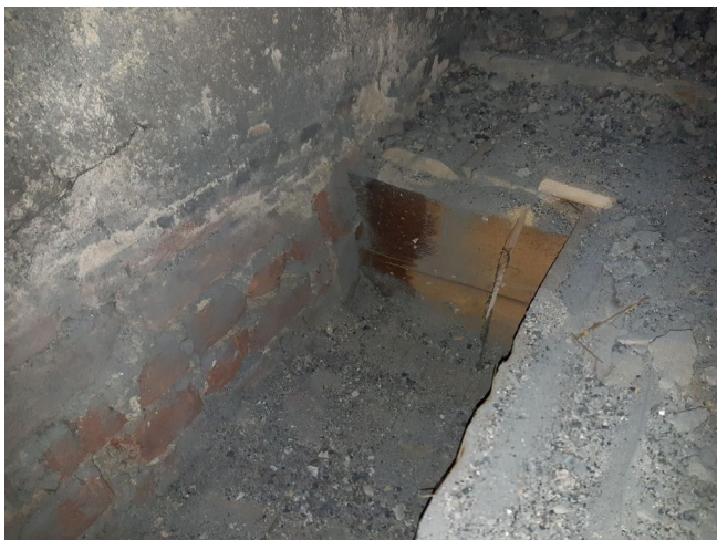
foto/18/ Pohled na zhlaví v sondě S1 (bez poruch)
