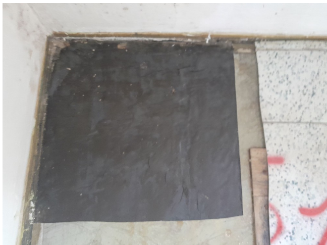
foto/74/ Pohled na antistatický nátěr/podložku pod spodní vrstvou PVC v sondě S13
