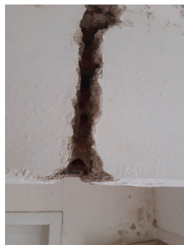
foto/89/ Pohled do sondy v průvlaku P1
