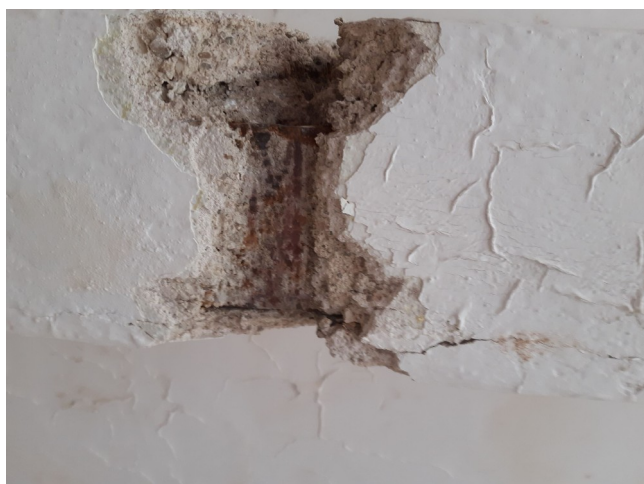
foto/88/ Pohled na ocelový nosník typu I tvořící průvlak P1
