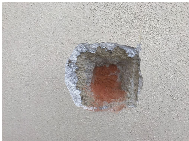
foto/114/ Cihelné zdivo nadzemních podlaží
