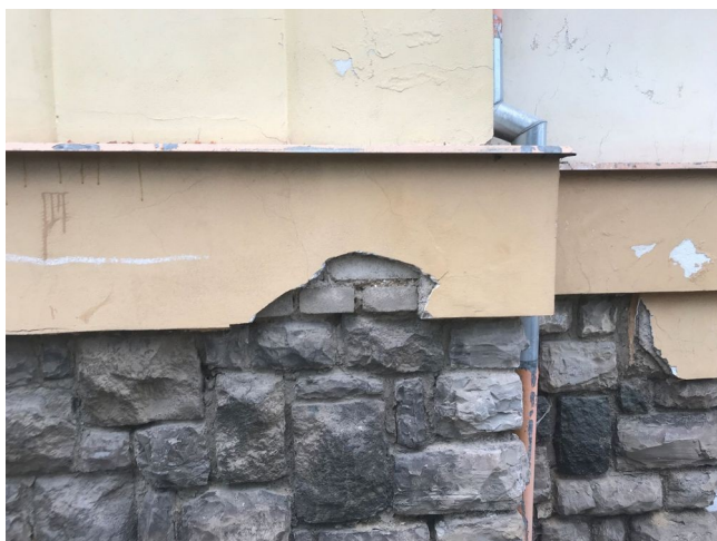
foto/112/ Římsa z betonových cihel
