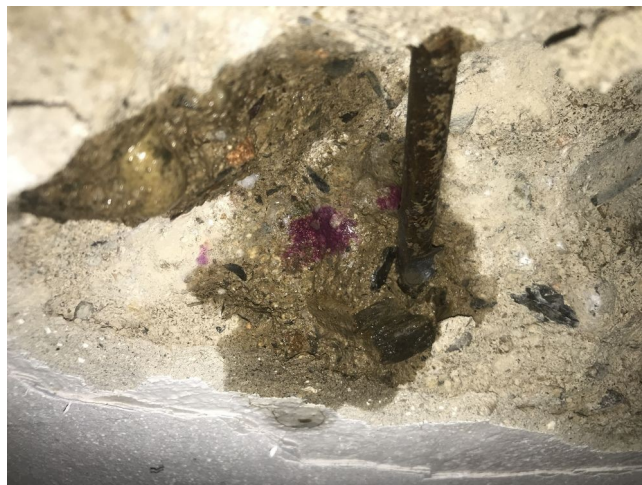
foto/85/ Zkarbonatovaný průřez betonu
