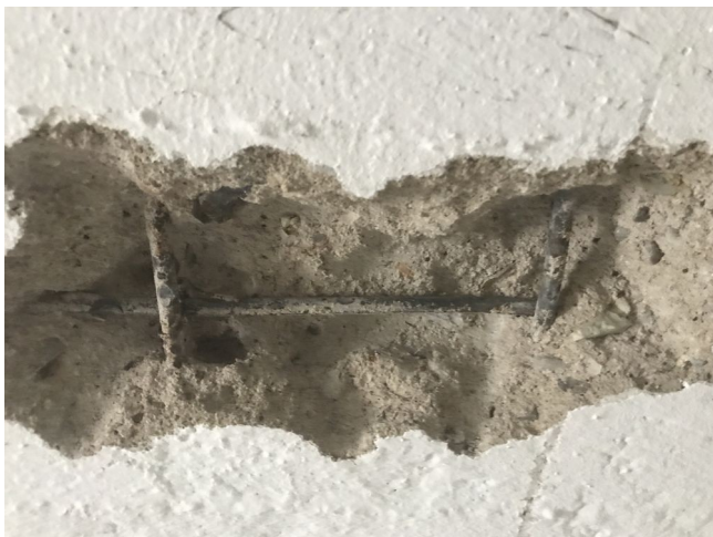
foto/78/ Hlavní nosná + rozdělovací výztuž
