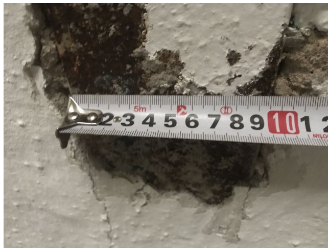
foto/79/ Šířka spodní pásnice nosníku I180
