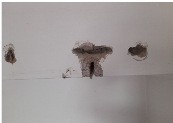
foto/92/ Pohled na místa odhalení výztuže v průvlaku P2
