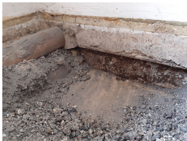
foto/71/ Pohled do sondy S12 s odhaleným ocelovým nosníkem
