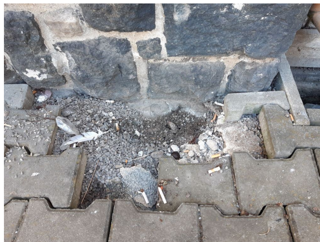
foto/15/ Ověření přítomnosti svislé hydroizolace
