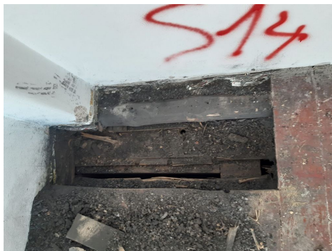
foto/45/ Pohled na otevřenou sondu S14
