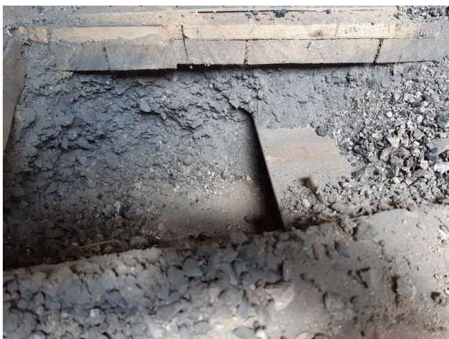
foto/58/ Pohled do sondy S8 s odhaleným ocelovým nosníkem
