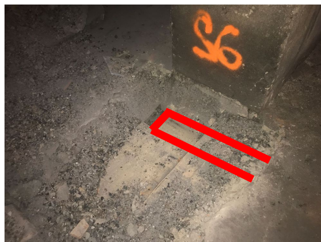
foto/35/ Pohled na uložení stropního trámu v sondě S6
