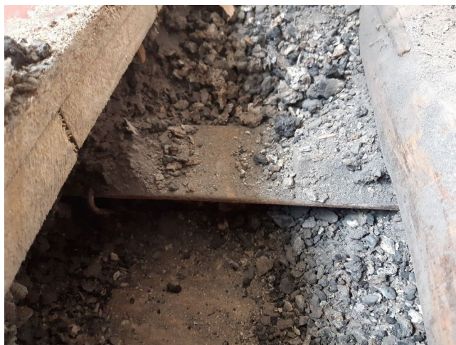
foto/67/ Pohled na ocelový nosník v sondě S11
