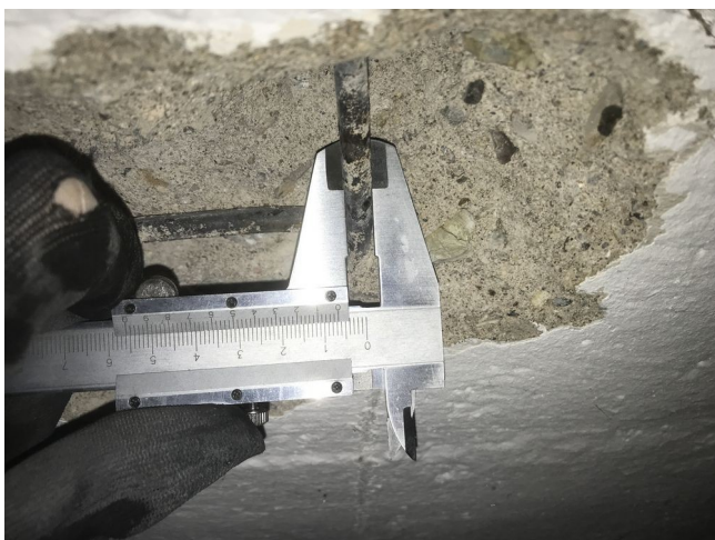
foto/76/ Výztužné pruty průměru 6 mm
