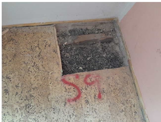
foto/61/ Pohled na otevřenou sondu s polštářem S9
