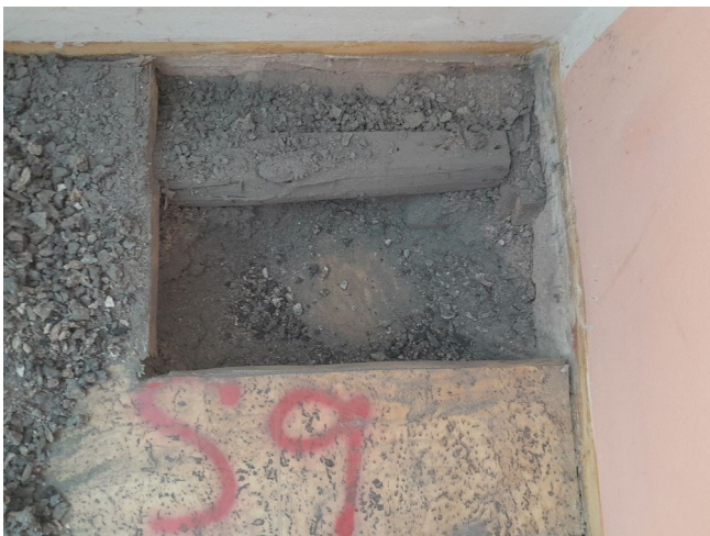
foto/62/ Pohled do sondy S9 s odhalenou stropní deskou
