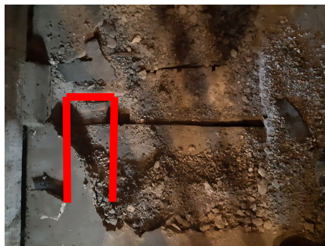
foto/25/ Pohled na uložení stropního trámu v sondě S3
