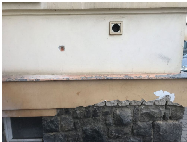
foto/113/ Římsa z betonových cihel
