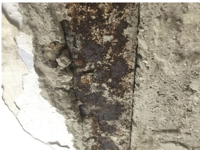
foto/82/ Pokročilá povrchová koroze pásnice nosníku
