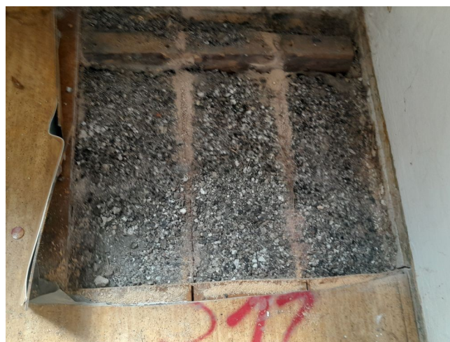
foto/69/ Pohled na otevřenou sondu S12 s odhaleným polštářem
