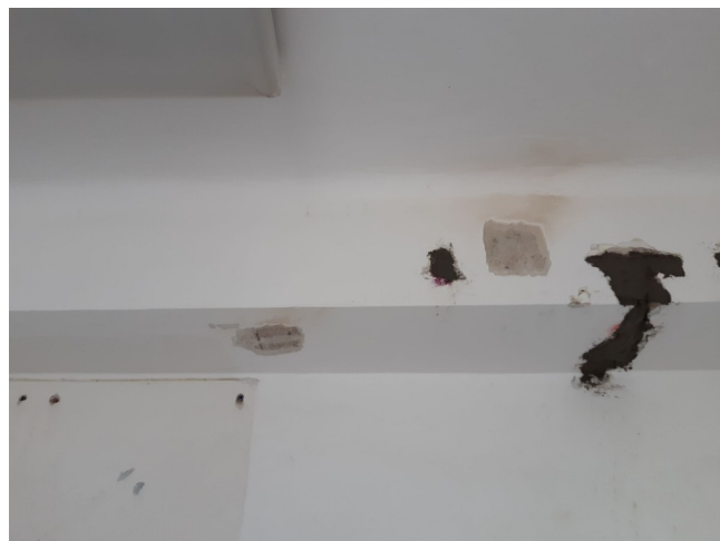
foto/91/ Pohled na místa zkoušek pevnosti betonu průvlaku P2
