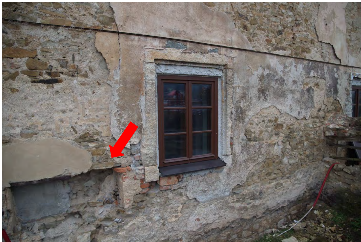
Foto 02 – detail severní fasády objektu – nutné vyspravení
