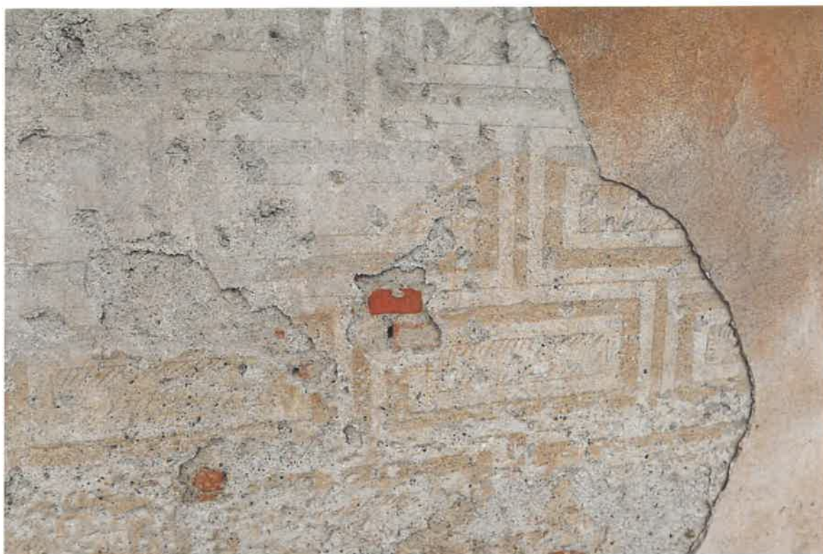
Foto – pohled na severní fasádu – detail s dochovanými sražitovými psaníčky po částečném odkryvu
