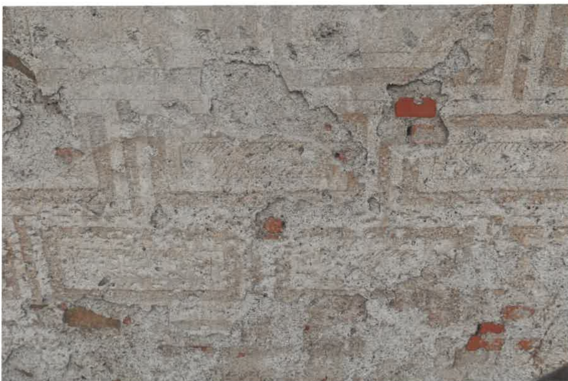
Foto – pohled na severní fasádu – detail s dochovanými sražitovými psaníčky po částečném odkryvu
