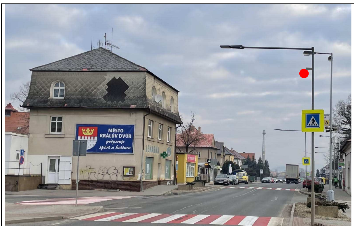
Obr. Umístění kamery C3 na stávajícím sloupu VO
