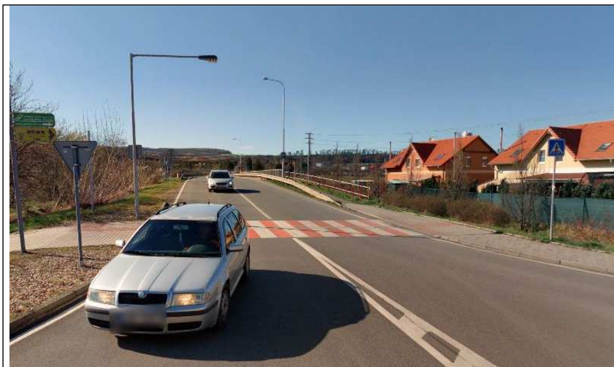
Obr. Pohled kamery na most směrem k nájezdu D5
