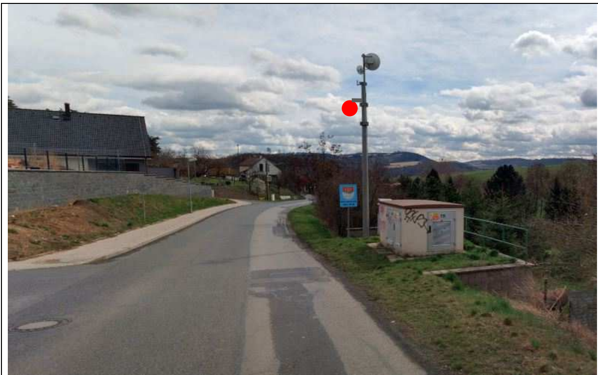
Obr. Umístění kamery C6 na stávajícím sloupu
