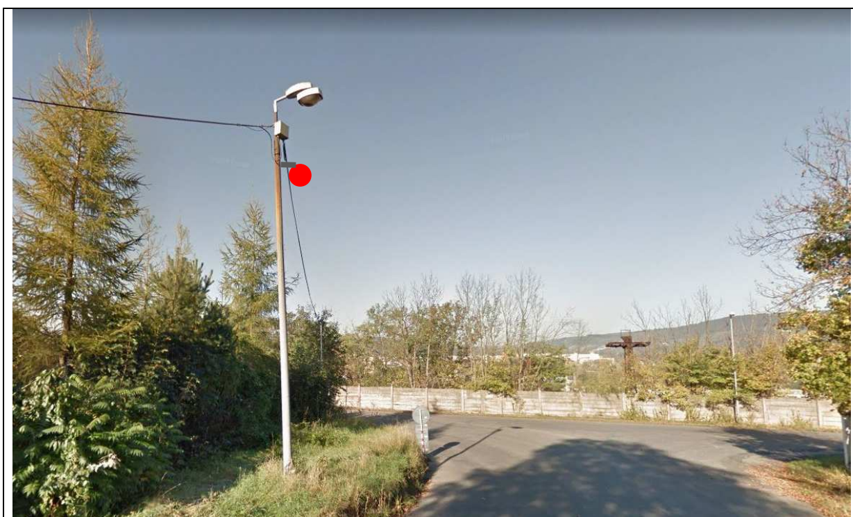
Obr. Umístění kamery C8 na stávajícím sloupu VO
