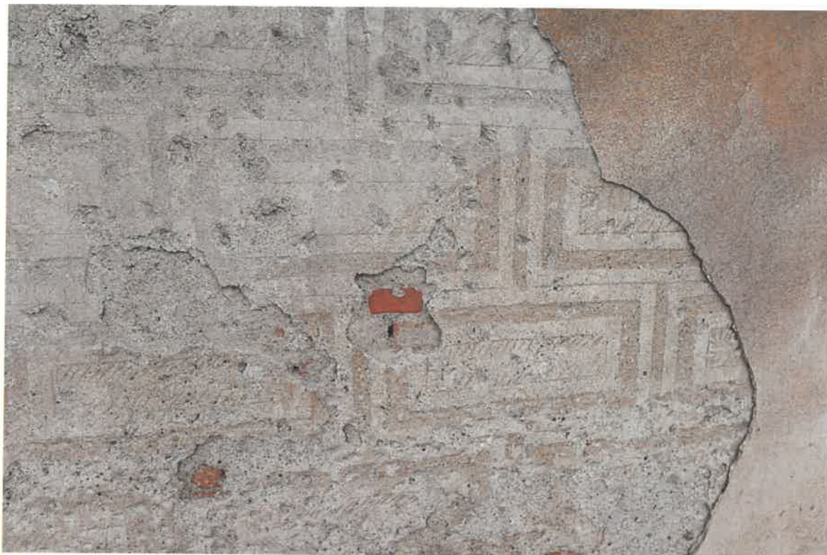
Foto – pohled na severní fasádu – detail s dochovanými sgrafitovými psaníčky po částečném odkryvu
