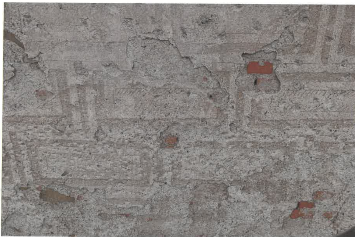
Foto – pohled na severní fasádu – detail s dochovanými sgrafitovými psaníčky po částečném odkryvu
