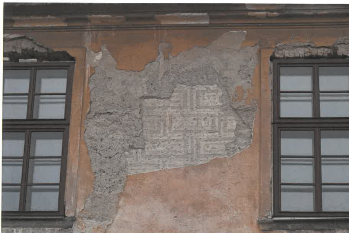
Foto – pohled na východní fasádu – detail s dochovanými sgrafitovými psaníčky po částečném odkryvu
