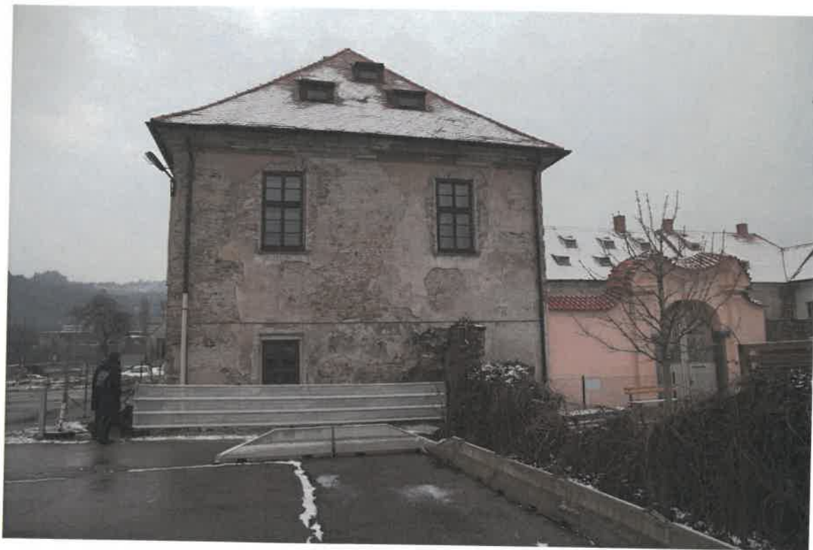
Foto 01 – celkový pohled na severní fasádu
