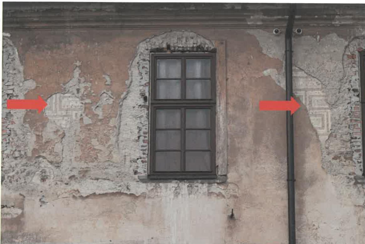
Foto – pohled na východní fasádu – detail s dochovanými sgrafitovými psaníčky po částečném odkryvu
